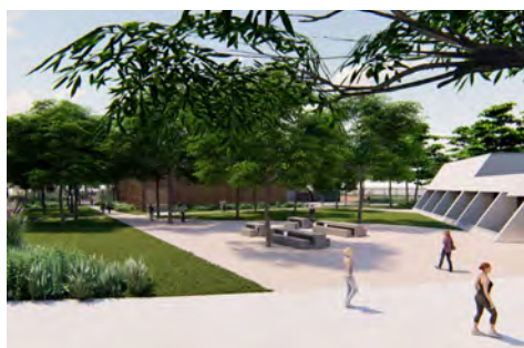
Le futur parvis du complexe sportif.
